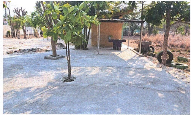
Foto 2: Reparación de drenaje.
