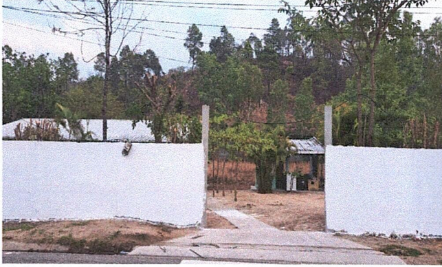
Foto 1: Reparación de muro perimetral.
