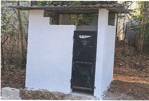
Foto 3: Reparación de baño.
